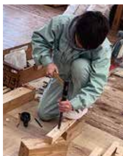
大工技能実習
