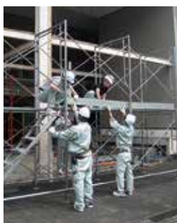
建築施工実習
