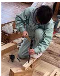
大工技能実習
