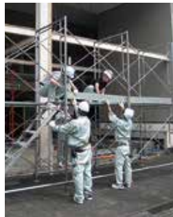
建築施工実習
