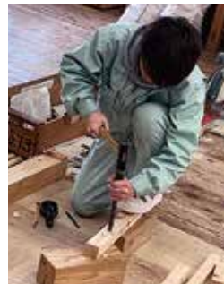
大工技能実習
